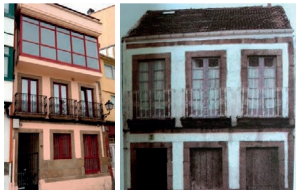
2.- El Hospital del Espíritu Santo. A la izquierda su estado actual rehabilitado para viviendas.
